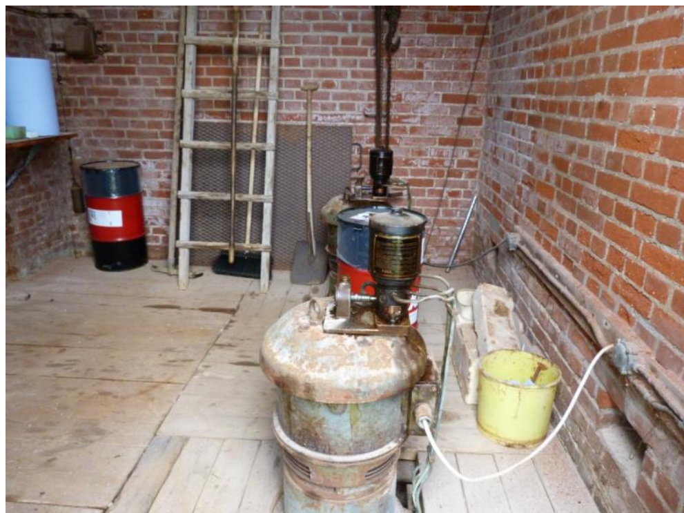
Figur 17. Inde i pumpehuset med de to fedtsmurte pumper fra 1960 set i august 2014.
