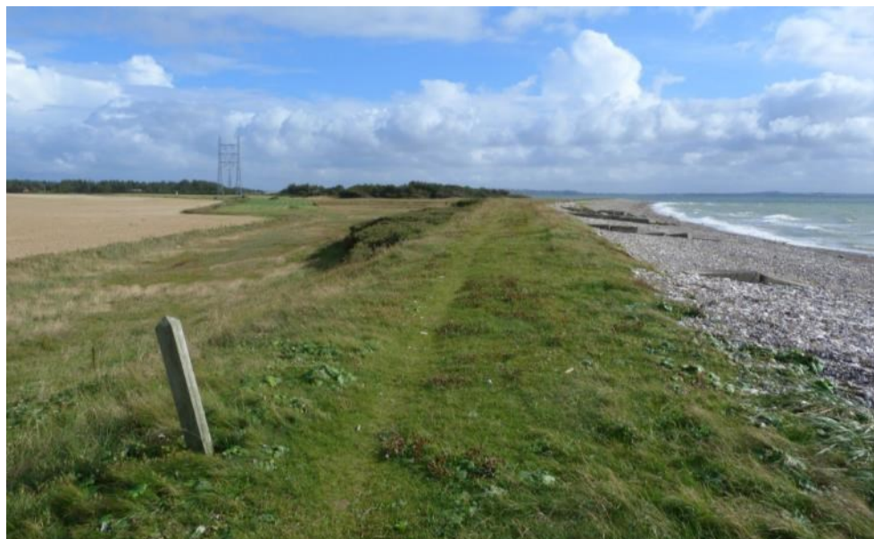
Figur 27. Strækningen af diget syd for Odby Sø's pumpestation, hvor det er foreslået at foretage åbningen ind til den nye kystlagune, set i august 2014.
