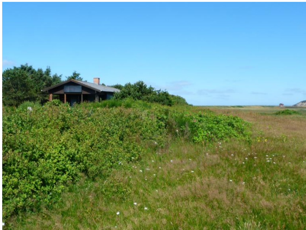
Figur 28. Sommerhuset Søvej 4, som foreslås hævet 0,2 m, og i baggrunden diget med Odby Sø's pumpestation set i juli 2015.
