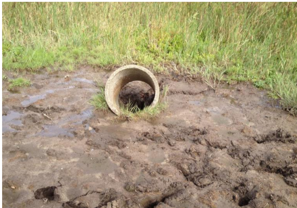
Figur 26. En sammenstyrtet drænbrønd i den nordlige del af Odby Sø omgivet af vand i terrænniveau i august 2014.
